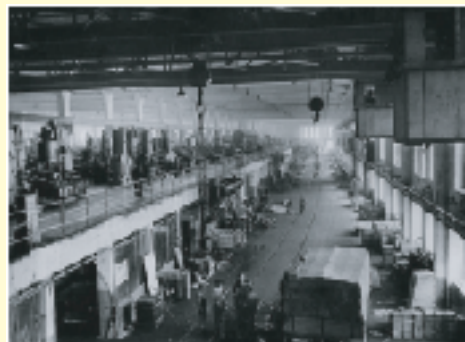
写真3 1949年当時のVW本社工場（工場建屋内通路に鉄道軌道が敷設されている） 出典：“Das VW - Werk 1949”（Historische VW's Braunschweig）
